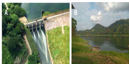
Figura 6. Represa y embalse Poza Honda, ubicado en Manabí, Ecuador. Fuente: (A) EPA EP (2020), (B) elaboración propia.
